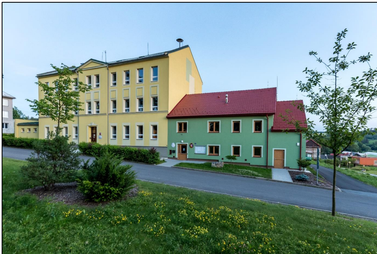
Obr. 14: Budova ZŠ a MŠ Huzová a obecního úřadu Zdroj: Petr Fiala (2019)
